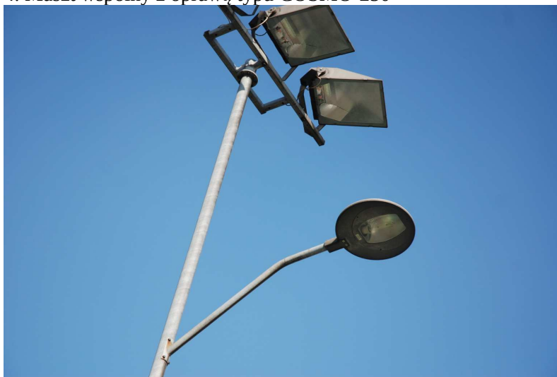
5. Maszt pojedynczy z oprawą typu LUNOIDA -250W
