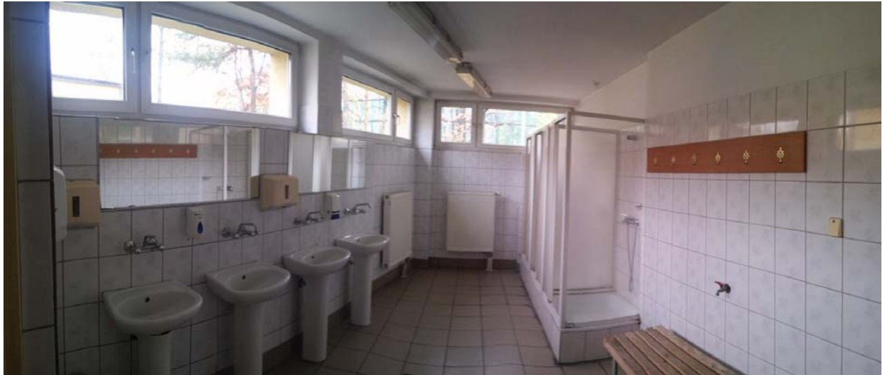
Foto.5 Pomieszczenie nr 3 – umywalnia
