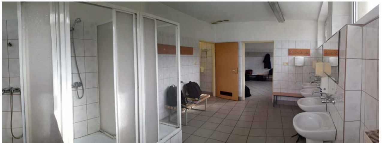
Foto.6 Pomieszczenie nr 3 - umywalnia
