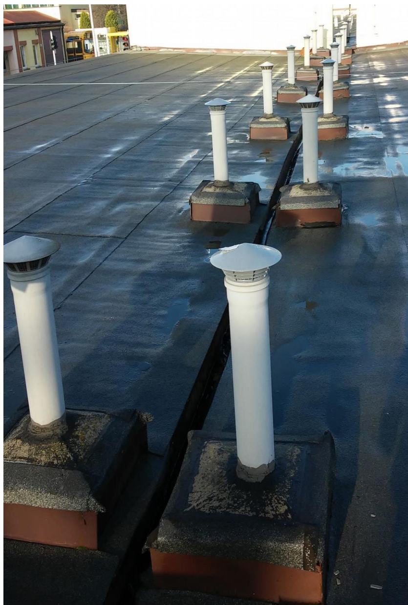
Foto.16 Widok dachu na segmencie 3 i 6, widoczne istniejące wywiewzaki
