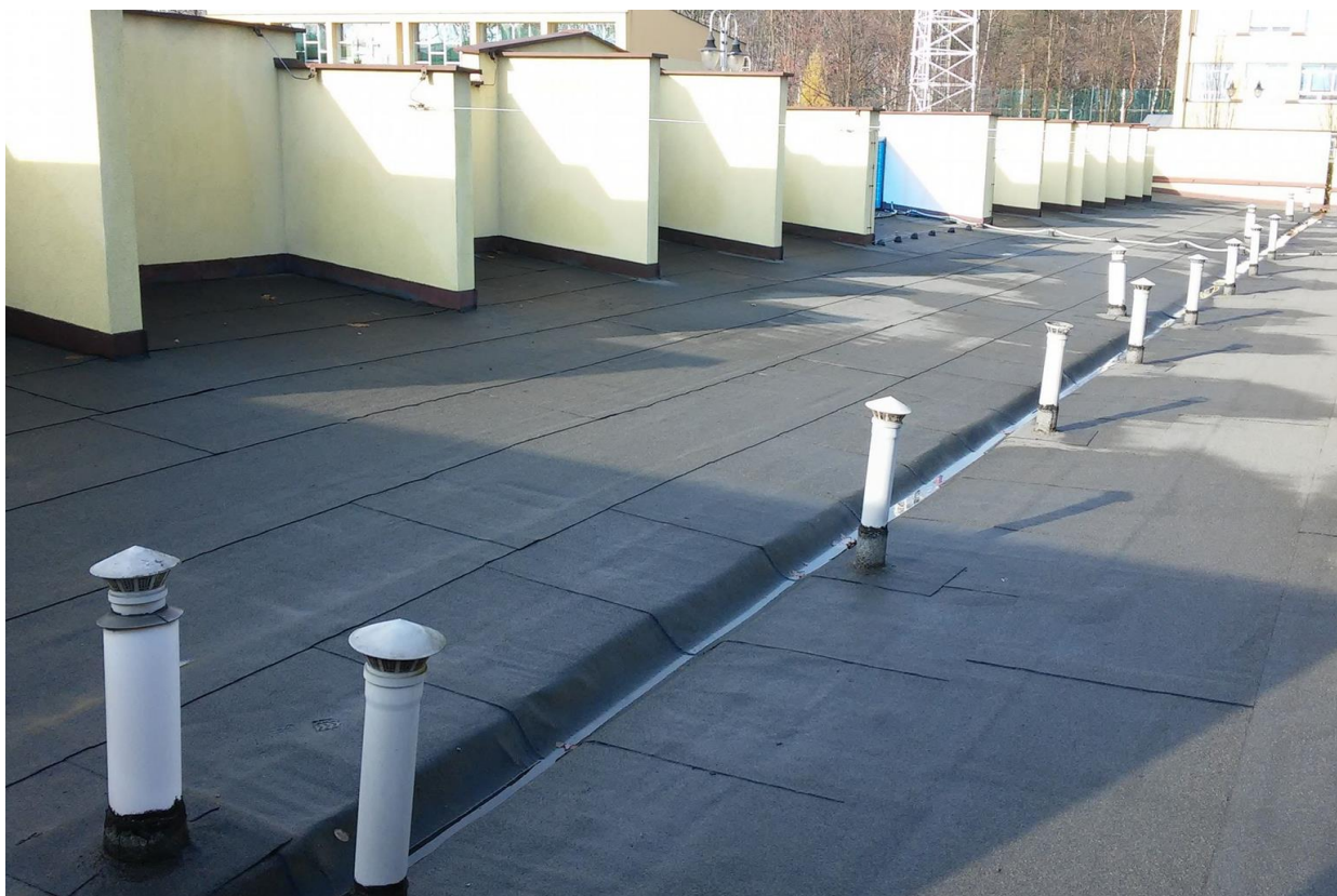
Foto.11 Widok dachu na segmentach 1,2,4,5
