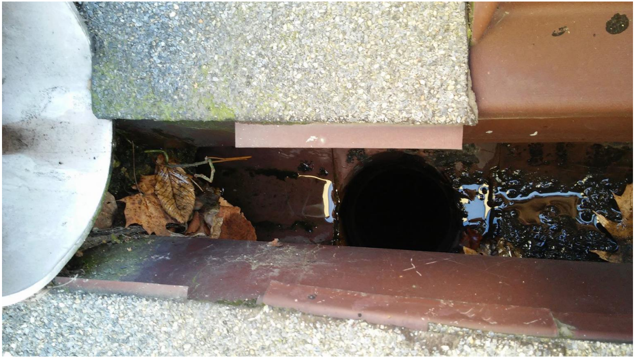
Foto.13 Koryto dachowe segmentu 3 i 6 z wpustem w osi 3
